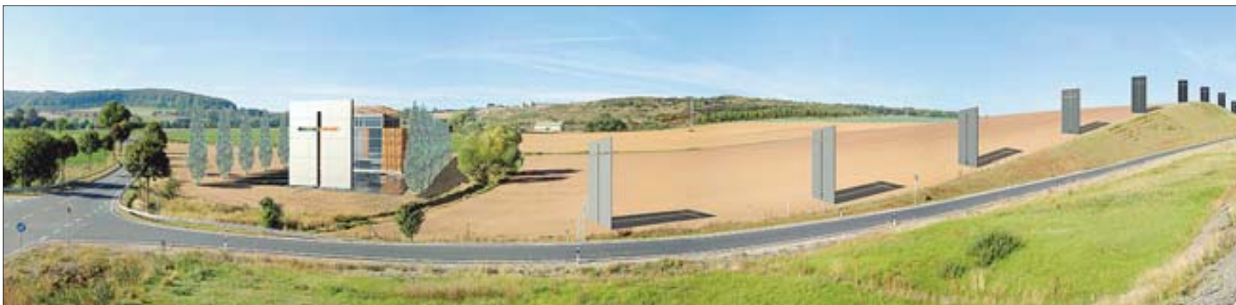
Panoramaansicht von der Autobahn 38: Später wird um die Basilika Gewerbefläche statt Landschaft zu sehen sein.
