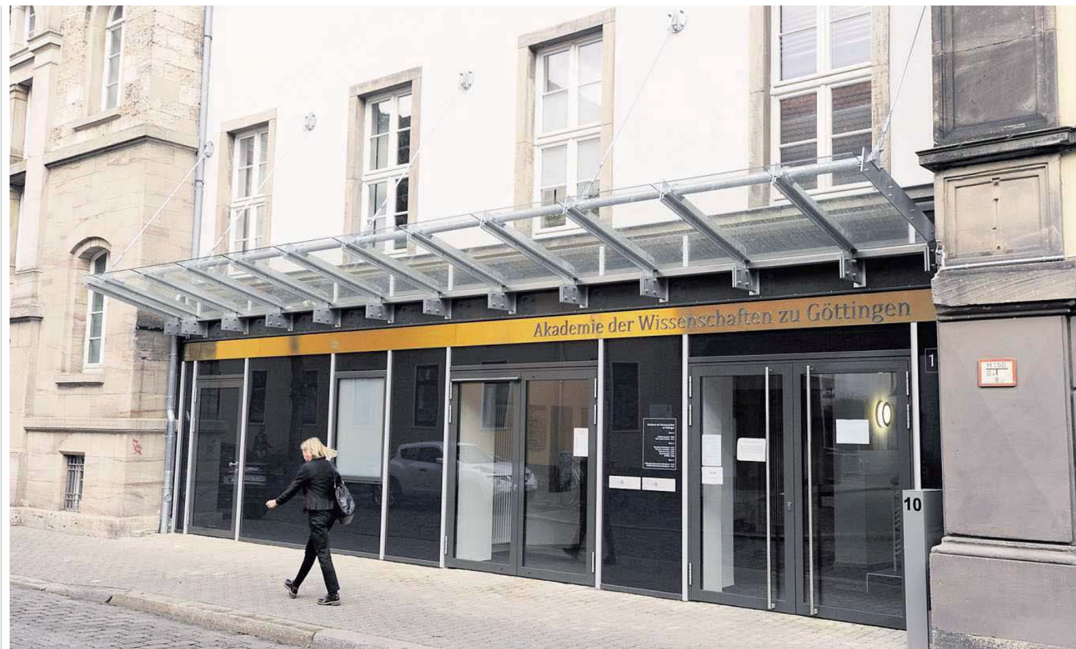
Neues Domizil für die Forschungsprojekte der Akademie der Wissenschaften: Das ehemalige Klinikgebäude in der Geiststraße.
